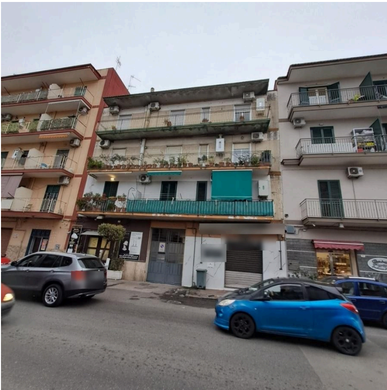
Edificio viale G. Marconi n.87
