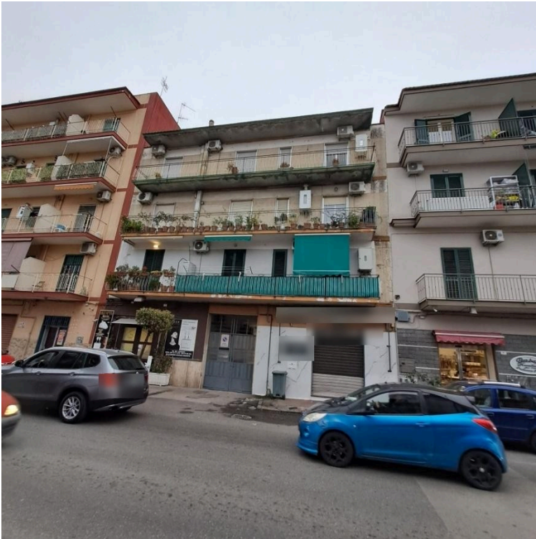
Edificio viale G. Marconi n.87-89
